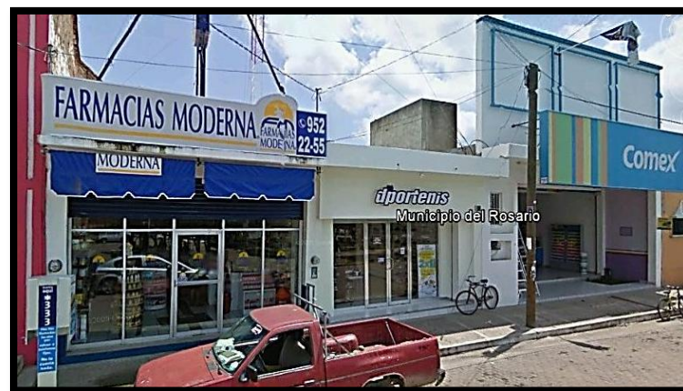
NO ADECUADO: fachadas de farmacia, deportenis y comex que no se adecúan al contornos.
